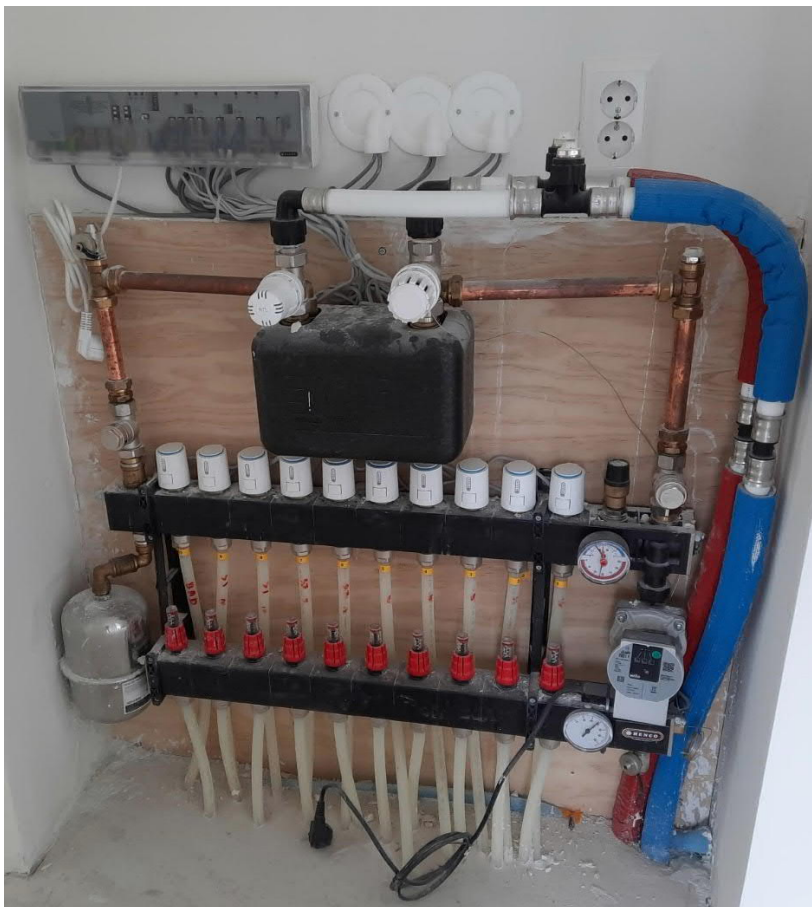
Overzicht vloerverwarming verdeler met naregeling per vertrek
